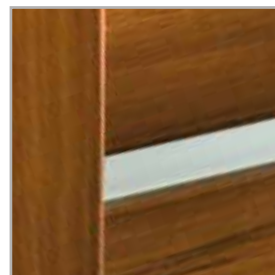
połączenie ramiaka, paneli i szyby
