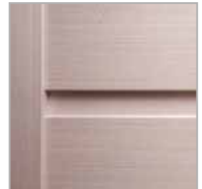
połączenie paneli, płyciny i ramiaka
