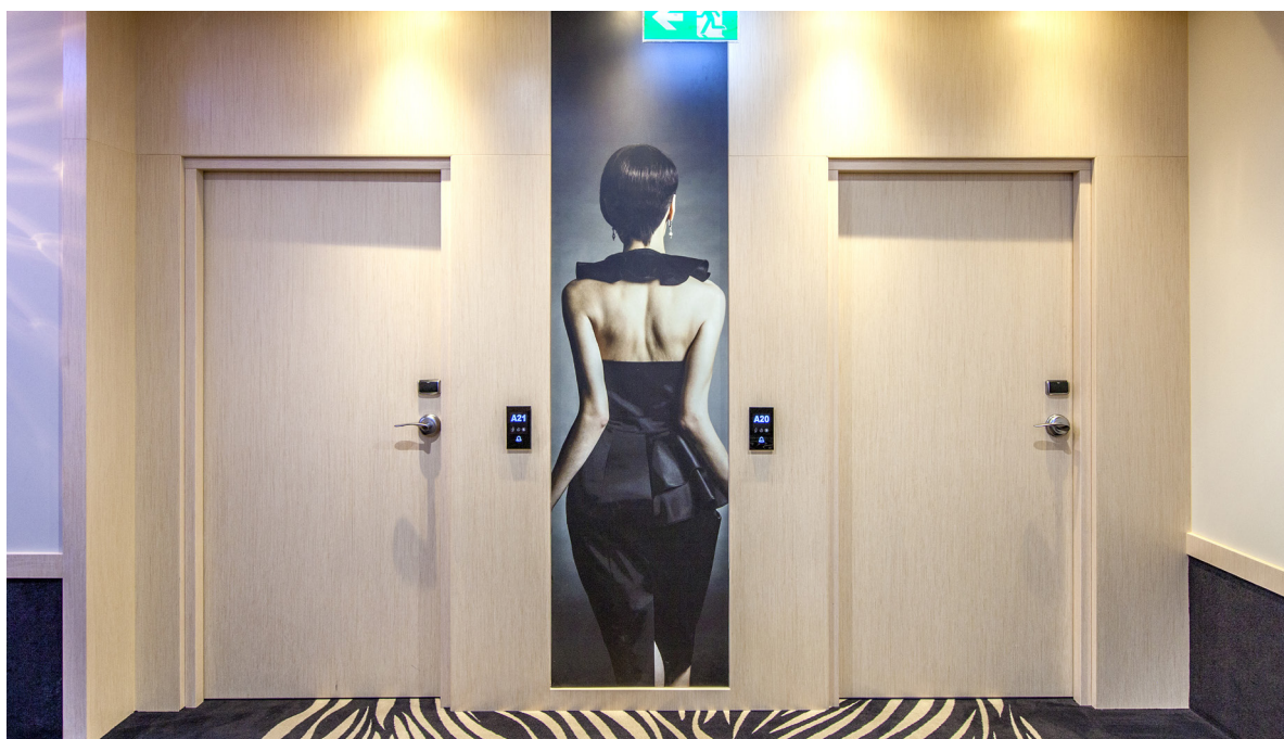
drzwi przeciwpożarowe FR EI30 SR 42, ościeznica stała drewniana
