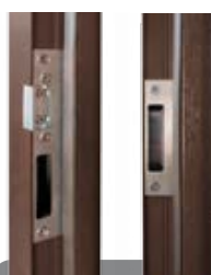
otwory zaczepowe ościeżnicy aluminiowej
