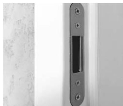
zaczep zamka magnetycznego w ościeżnicy
