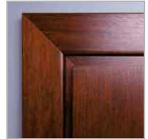
łączenie opasek pod kątem 45°
