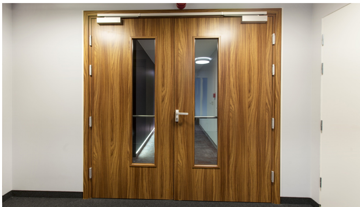
drzwi przeciwpożarowe FR EI30, ościeżnica stała drewniana
