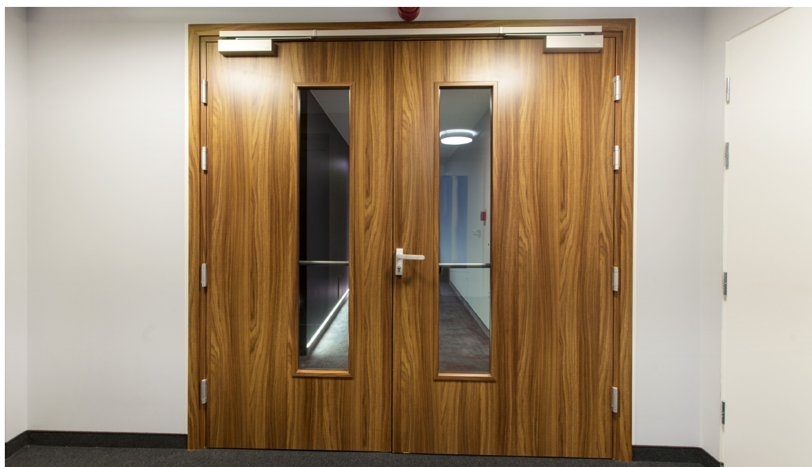
drzwi przeciwpożarowe FR EI30, ościeżnica stała drewniana
