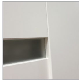
specjalne fazowanie na łączeniu ramiaków
